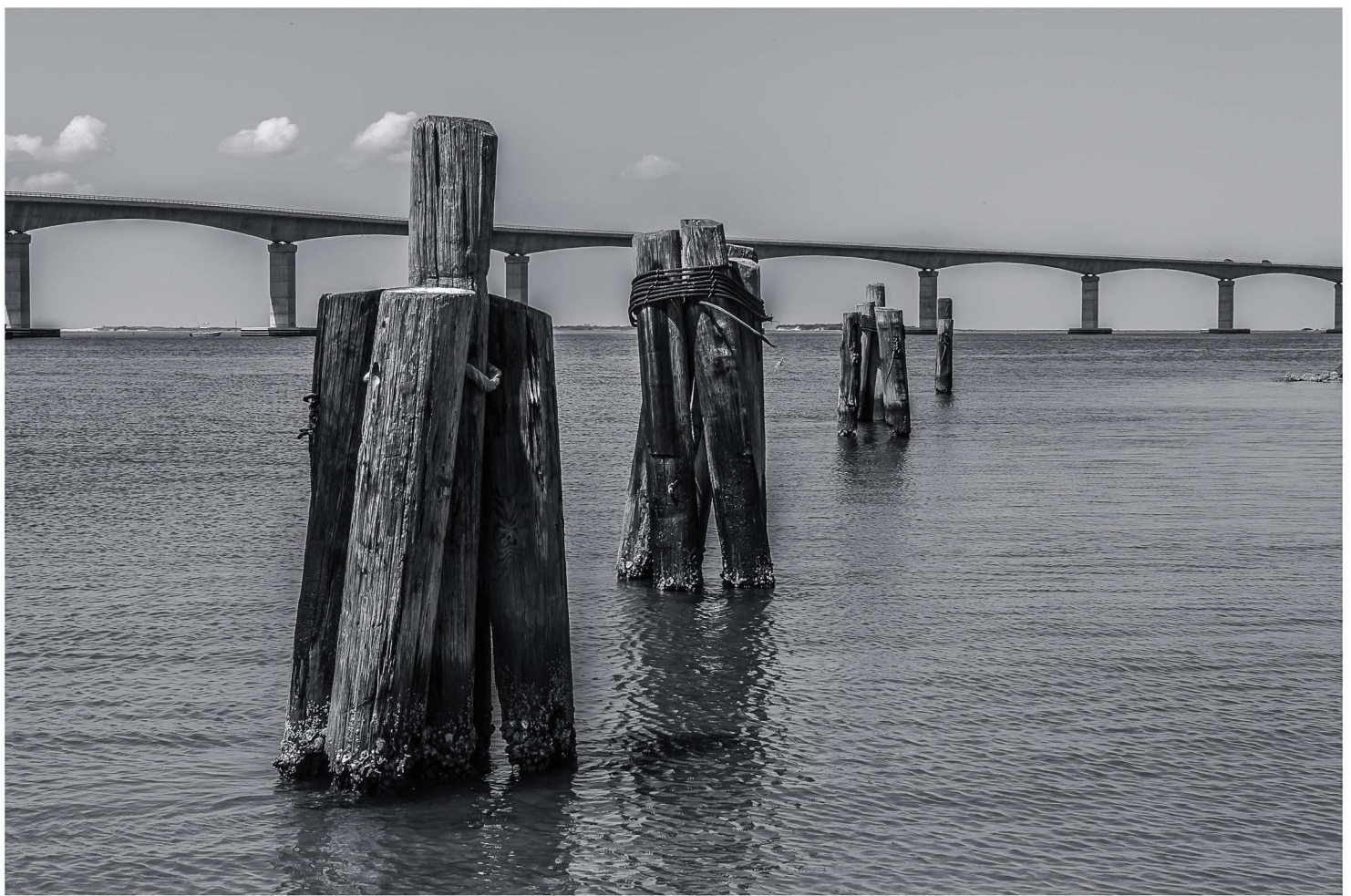
Le Bonner Bridge à Rodanthe en Caroline du Nord Côté sud du pont, le Oregon Inlet Life Saving Station, édifice historique utilisé jusqu'en 1988 par les gardes côte (page 16). Une des rares stations encore debout, les autres ayant été emportées par les ouragans.
